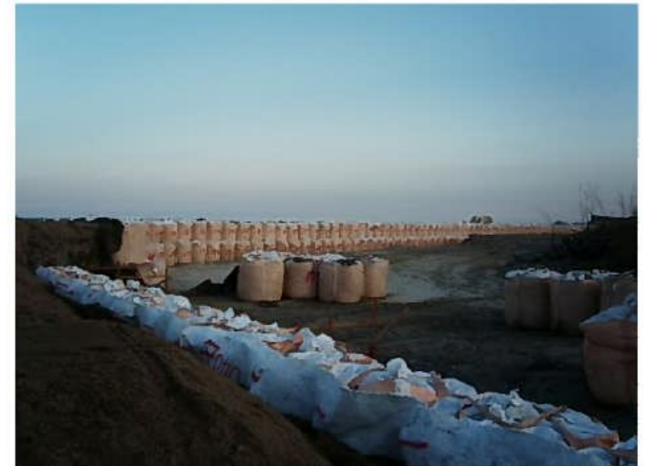
海岸沿いには 土のうが設置されていた
