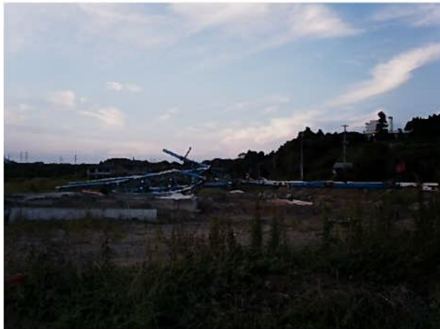
津波の被害② 橋が無惨な状態に
